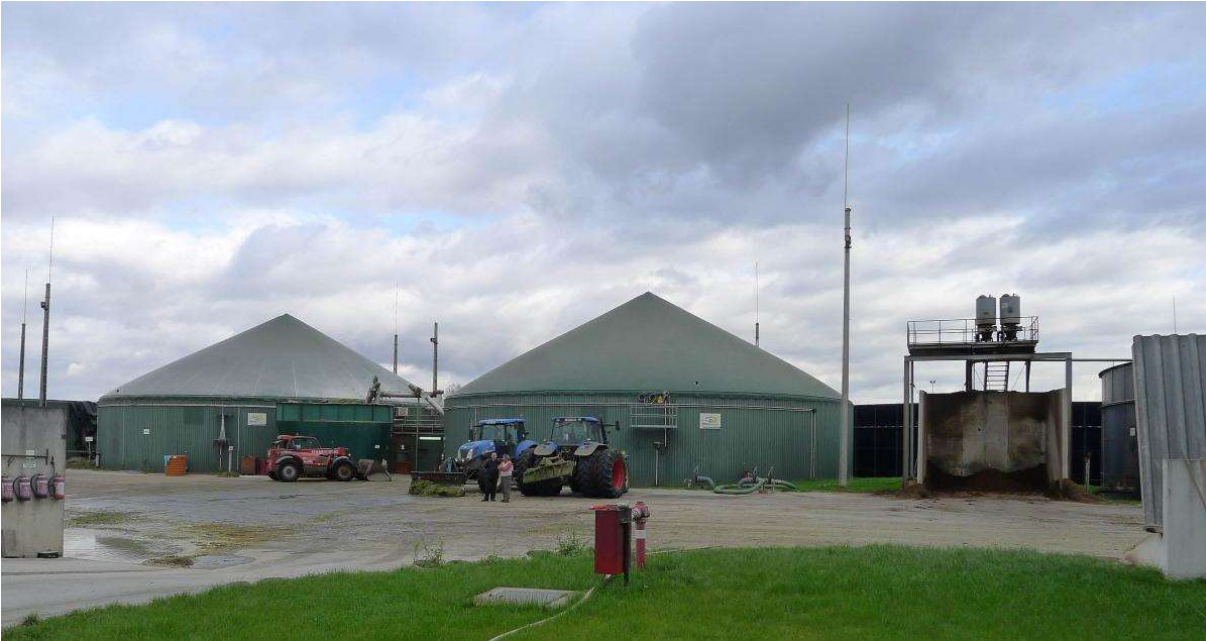
Figure Integrated biogas power plant and bioethanol factory in Kaposzsekcső, Hungary (Source: https://agroforum.hu/agrarhirek/megujulo-energia/bioetanol-es-biogaz-egymas-mellett-kaposzsekcson-kepek/ )
