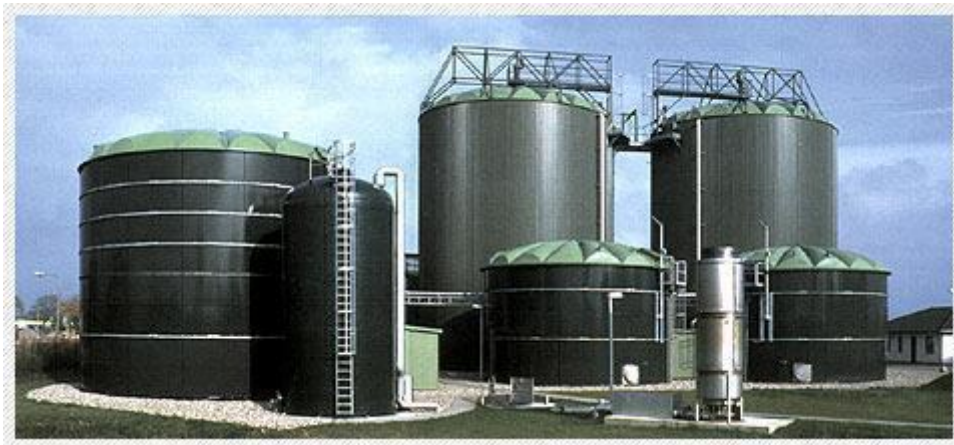
Figura 9. Obras de biogás
