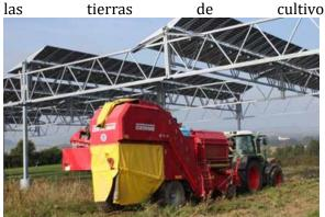
Los sistemas con soportes altos albergan un gran potencial de efectos sinérgicos. Sin embargo, deben permitir el cultivo bajo los módulos fotovoltaicos (figura 14).
