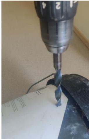
2. Perfora un agujero para el aliviadero y luego conecta el tubo. El tubo interior debe quedar a 5 cm del fondo del cubo. El exterior debe ser tan largo que pueda fluir hacia el segundo recipiente. Cierra el agujero herméticamente.
