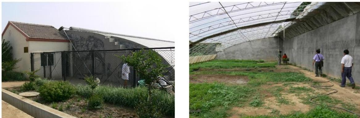
Figura 5. La alfombra se enrolla en la parte superior del túnel invernadero.
