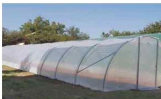
Figura 1. Invernadero túnel EVA con filtro UV.
