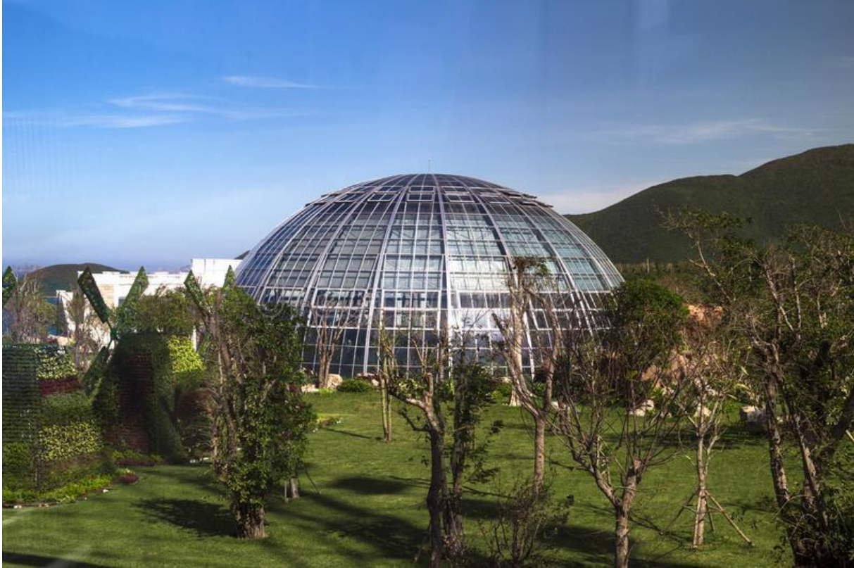
Figura 11 Edificio a cupola in vetro e metallo del Giardino Botanico in Vietnam, nella città di Nha Trang
